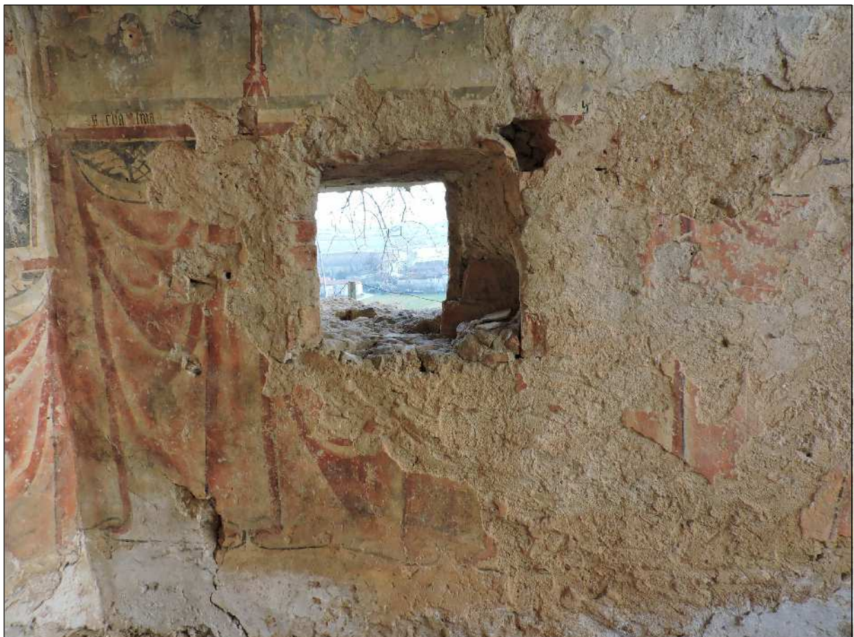
INTERNO, particolare della FINESTRA lato SUD
