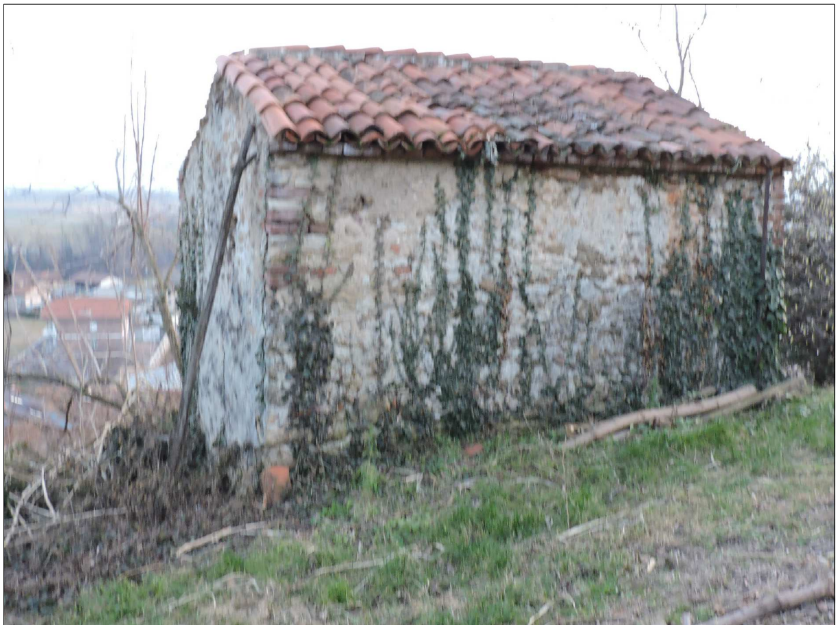
ESTERNO, vista del LATO NORD
