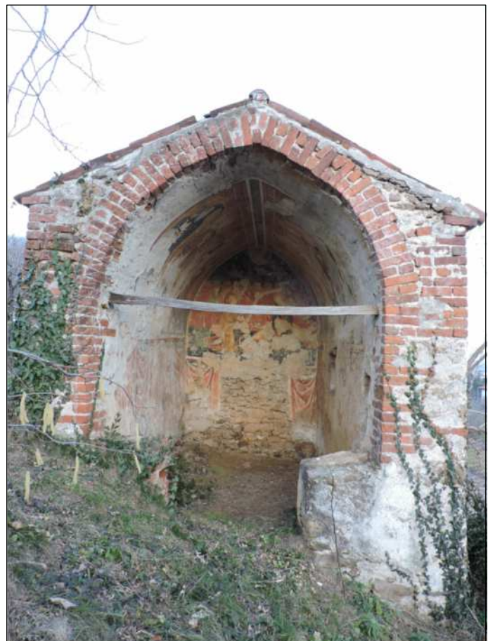
ESTERNO, vista del LATO OVEST
