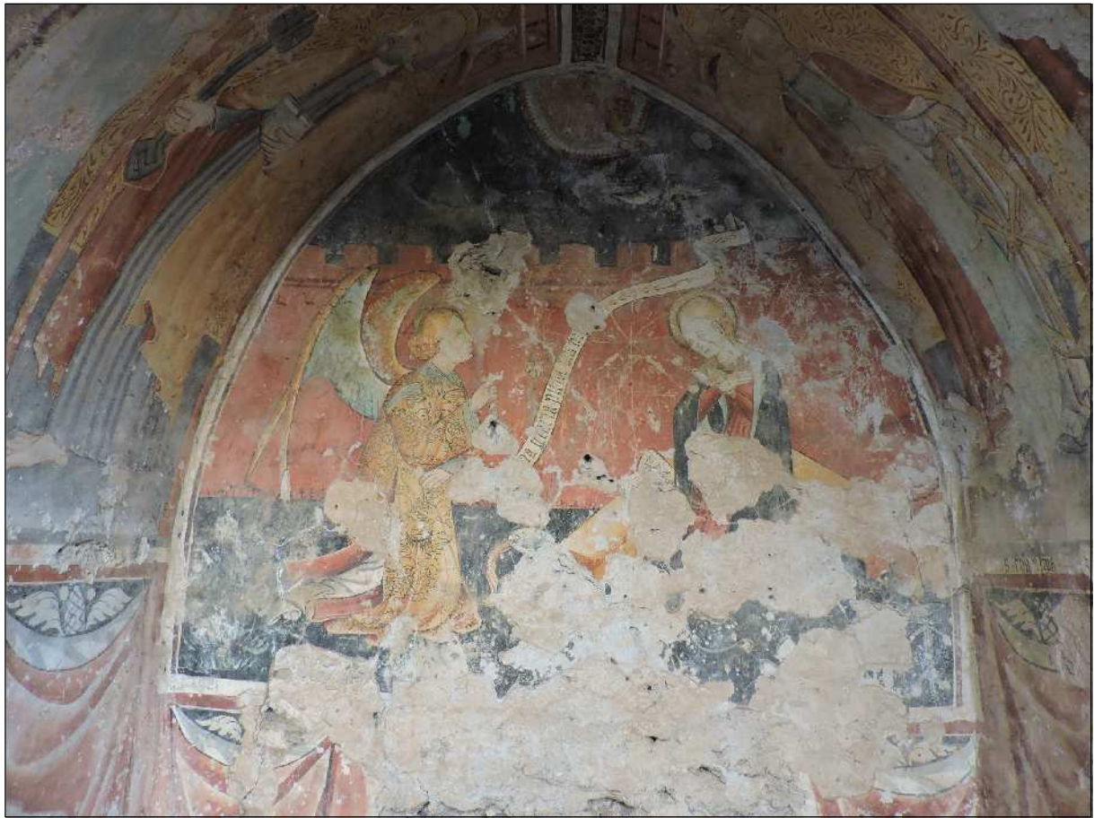
INTERNO, particolare dell'ANNUNCIAZIONE
